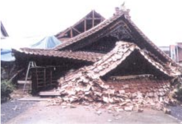
地震により倒壊した出雲大社・上道教会(境港市)
