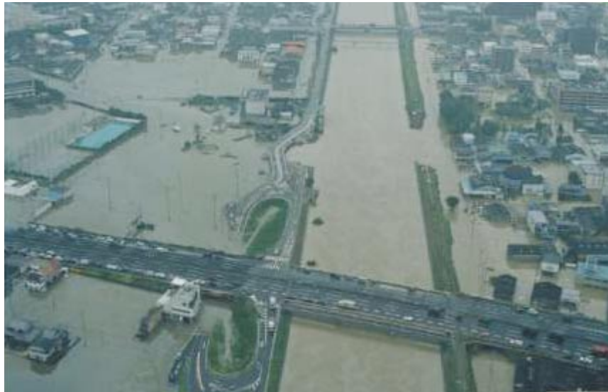
新川が破堤し浸水した名古屋市西区
